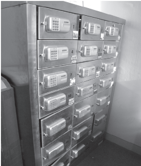
프런트에 설치된 안전금고
